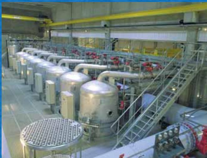
Cette filtration élimine toute présence accidentelle de matières en suspension susceptibles de venir colmater et endommager les membranes de nanofiltration. L'eau, injectée à faible pression (environ 3 bars), traverse les cartouches filtrantes des microfiltres qui retiennent toutes les particules supérieures à 6 microns. Puis l'eau est envoyée sous haute pression (8 à 15 bars) dans les unités de nanofiltration.
