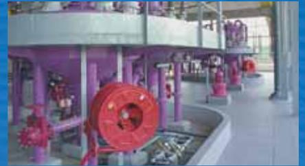
L'eau est débarrassée de 95 % des fines particules en suspension qui la rendent impure et la troublent. Elles sont agglomérées entre elles sous l'effet d'un coagulant. Les flocons qui se forment alors sont lestés par du microsable et tombent par gravité au fond du bassin de décantation. Dans les décanteurs ACTIFLO® (brevet conjoint SEDIF-OTV), la circulation de l'eau le long d'étroites lamelles inclinées augmente la vitesse de décantation.
