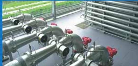
Une désinfection aux ultraviolets forme une ultime barrière de sécurité contre les bactéries et virus qui pourraient subsister dans l'eau nanofiltrée en raison d'un dommage accidentel sur une membrane.
