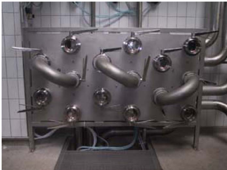
Fig. 1: Panel de distribución
