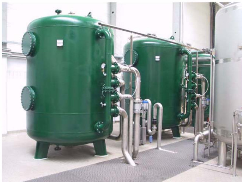
Fig. 3: Filtros de arena
