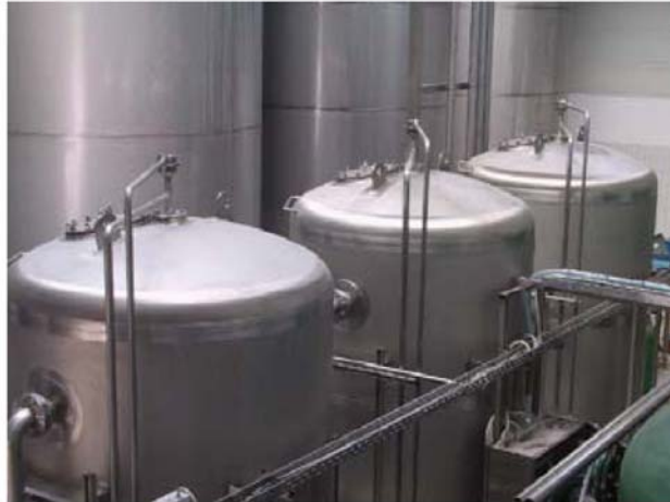
Fig. 8: Filtración de carbón activo
