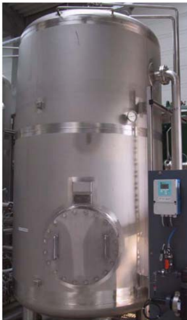
Fig. 7: Recipiente de carbón activo y medida de salida de agua
