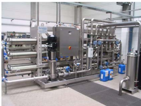
Fig. 9: Estación de Ósmosis Inversa
