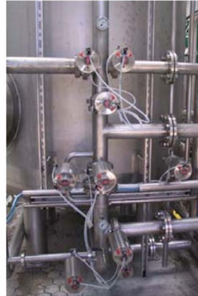
Fig. 6: Conducciones frontales Filtro de carbón activo
