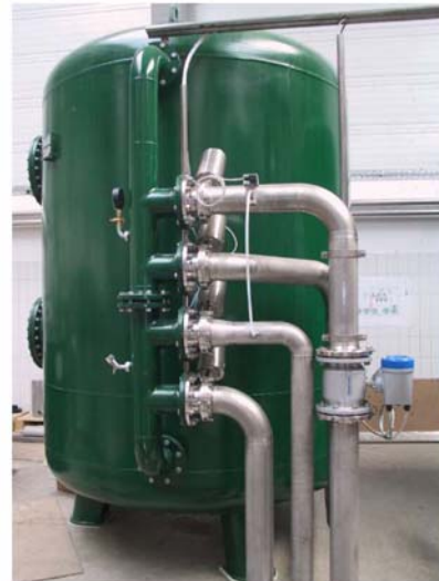
Fig. 2: Filtro de arena
