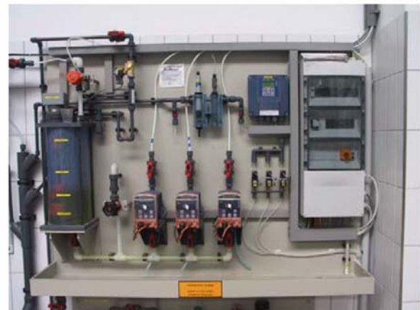
Fig. 5: Ejecución de una estación de dióxido de cloro
