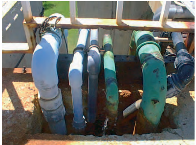
Figura 010. Sistema para dosificación mecánica de productos de tratamiento.
