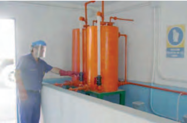
Figura 122. Operario realizando tareas de dosificación.
