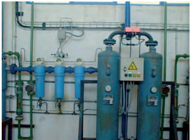
Figura 018. Parte del sistema de ozonización.
