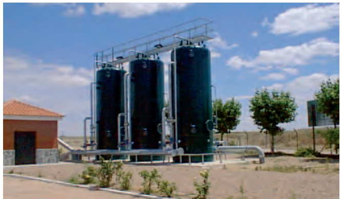
Figura 015. Torres de carbón activo.
