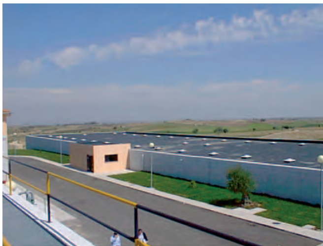
Figura 001. Depósito de agua tratada.
