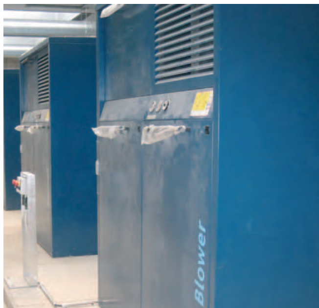
Figura 053. Soplantes encapsuladas.
