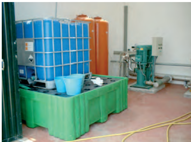
Figura 137. Cubetos de retención.
