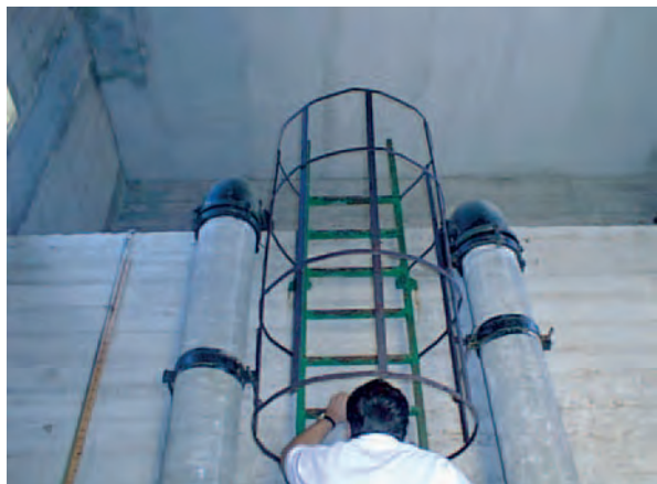
Figura 030. Acceso a depósito.
