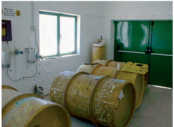
Figura 017. Instalación de cloro gas.
