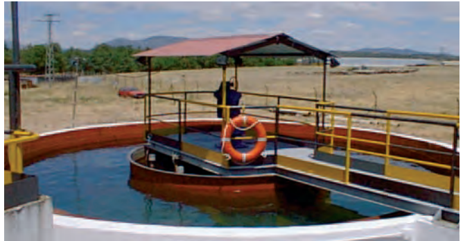
Figura 002. Decantador.
