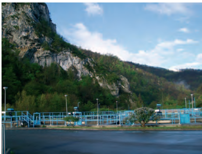
Figura 004. Vista general de una ETAP.
