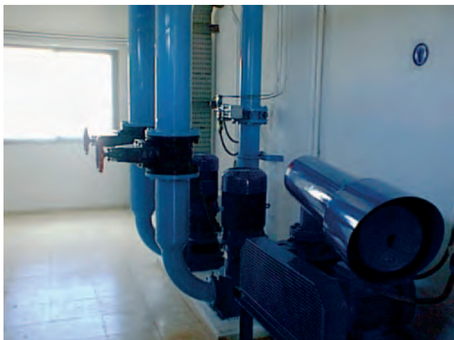
Figura 052. Otro ejemplo de bomba soplante.
