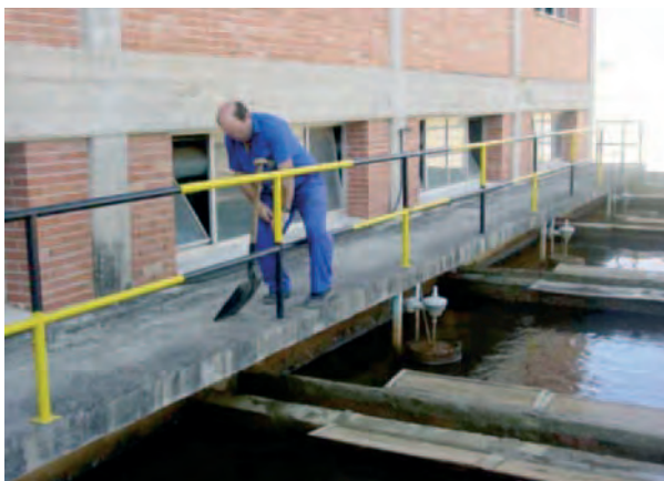
Figura 098. Inicio de trabajos de limpieza en aireadores.
