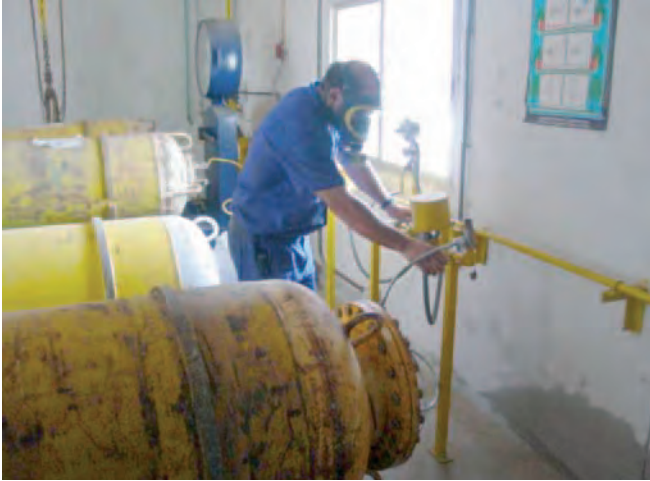
Figura 130. Cambio de contenedores de gas.
