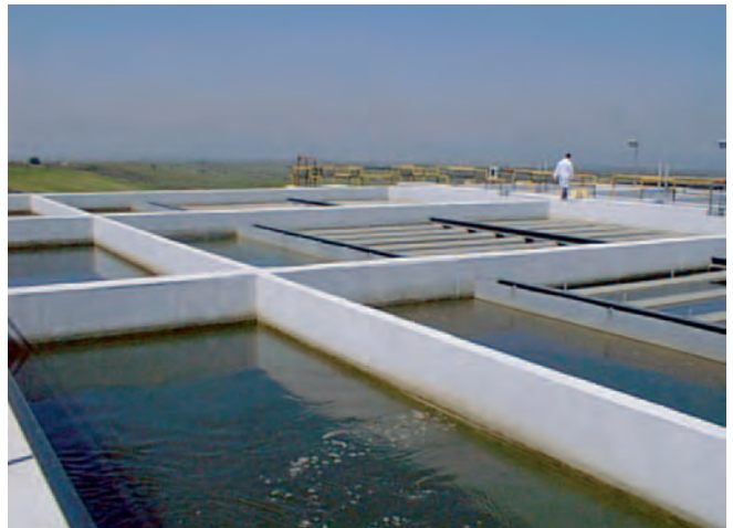
Figura 112. Zona de aireación, sin ningún tipo de protección.
