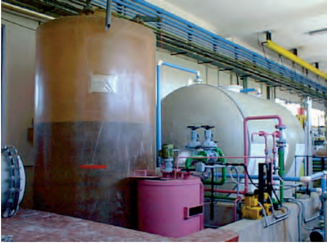
Figura 140. Productos químicos de tratamiento con sus respectivos cubetos de retención.
