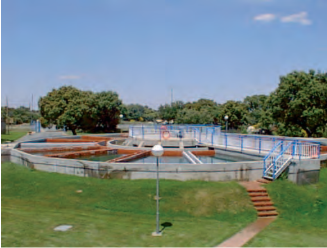
Figura 013. Decantador circular:
