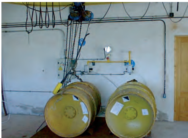
Figura 132. Bombonas de cloro gas.
