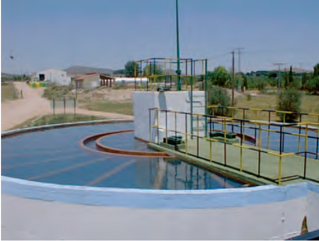
Figura 110. Decantador protegido con barandillas aunque sin flotadores.
