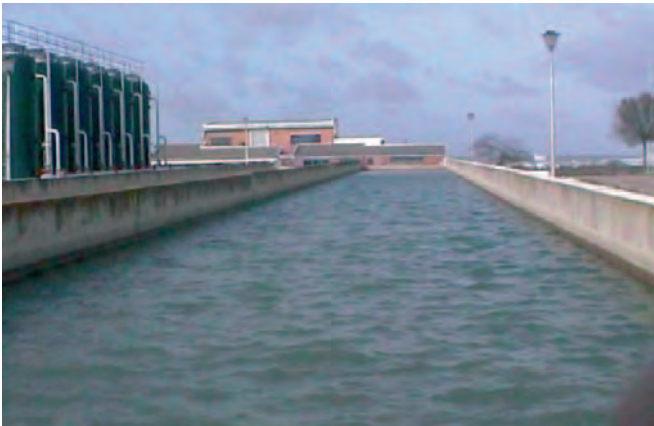
Figura 014. Decantador rectangular:
