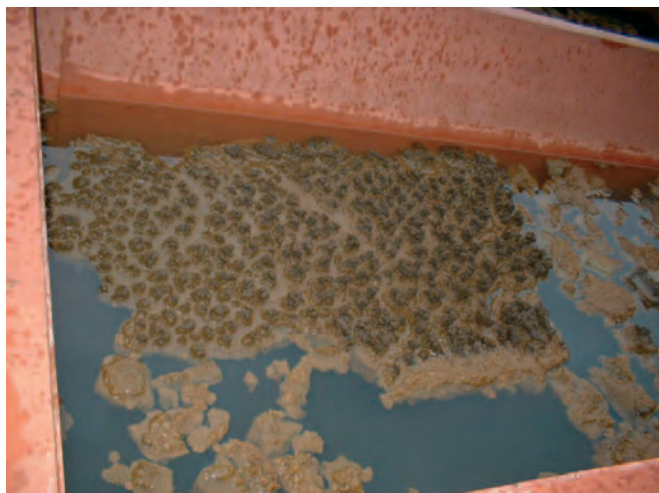
Figura 008. Materia orgánica acumulada en zona de pretratamiento.
