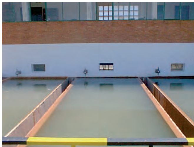
Figura 011. Línea de desarenado.
