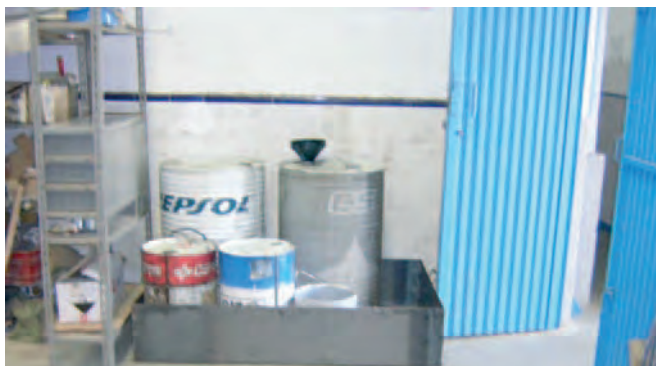
Figura 138. Aceites y grasas en cubeto de retención.
