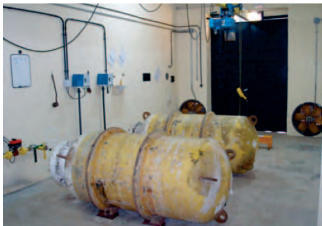
Figura 059. Contenedores de cloro.
