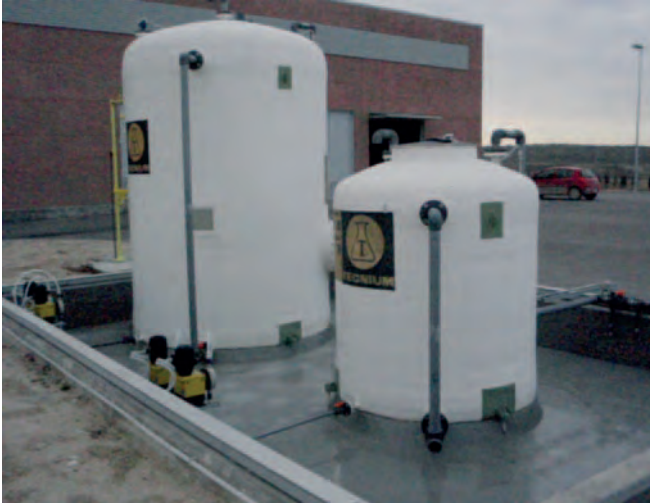
Figura 139. Cubeto de retención en exteriores.
