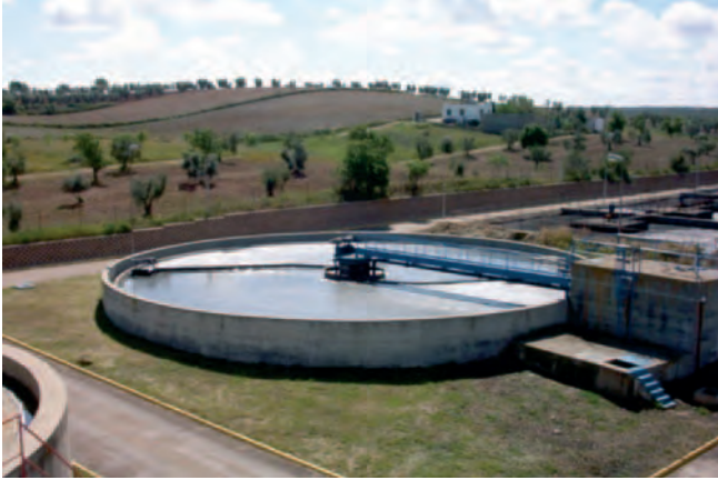
Figura 099. Decantador.
