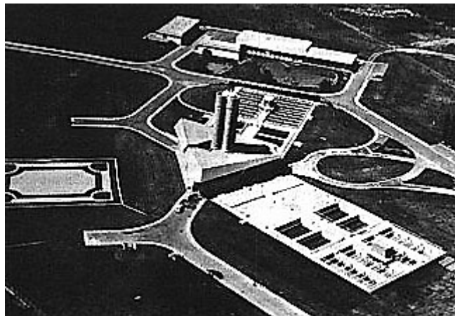
Fig. 100.- En primer plano, decantadores SUPERPULSATOR de 476 m 2 de superficie. Caudal 3100 m 3 /h. Estación de MORSANG-sur-SEINE. Abastecimiento de agua potable a la región parisiense sur.
