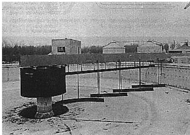
Fig. 82. Decantador de rasquetas, de 24,50 m Ø, equipado con rasquetas montadas en «celosía». Tratamiento de aguas residuales de REIMS (Marne).
